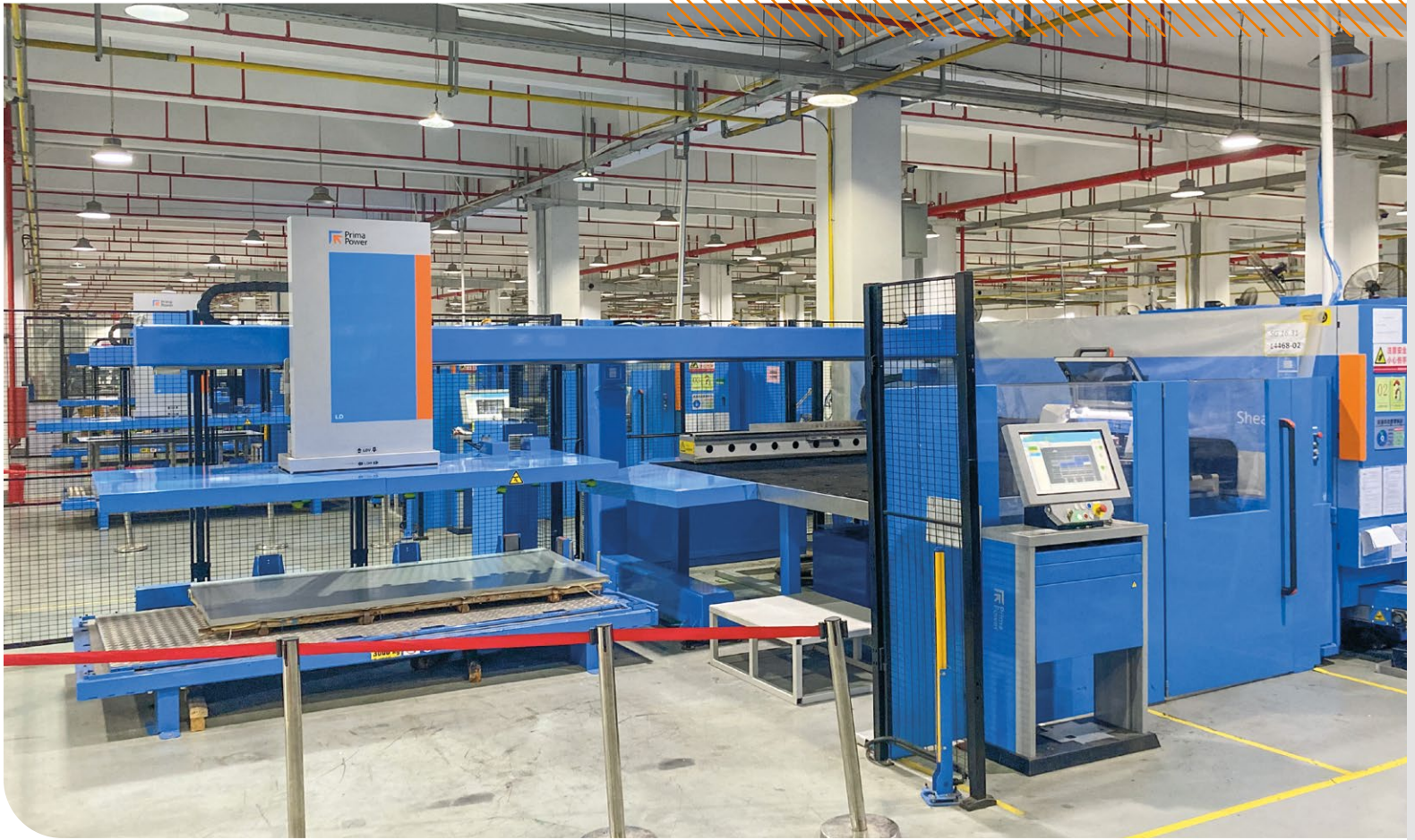
Oltre alla linea PSBB, nello stabilimento SUNSEA AIOT sono installate 3 macchine Shear Genius SG 1530 e 5 presso piegatrici eP 1030.
